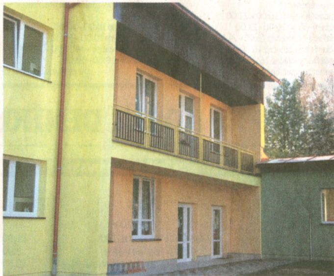
Nová fasáda prozářila budovu k nepoznání. Barevné fasády byly součástí rekonstrukce školek za 17 milionů. Foto: MÚ Jilemnice
